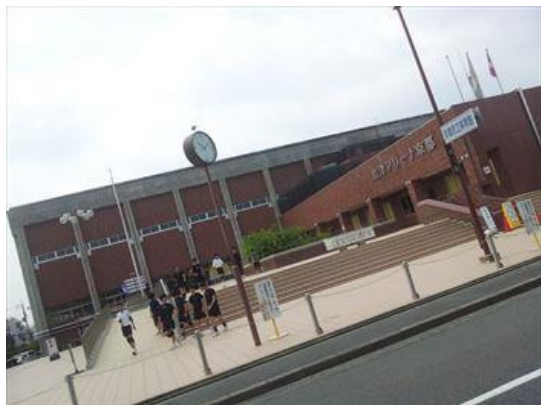
島津アリーナー京都・ 京都府立体育館(外観)
